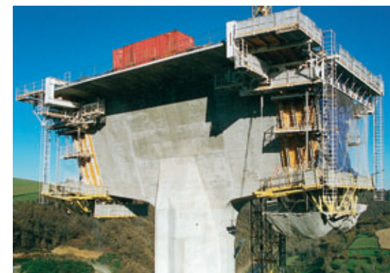
Photo 7 L'équipage mobile des grands fléaux Travelling formwork for large cantilever arms
