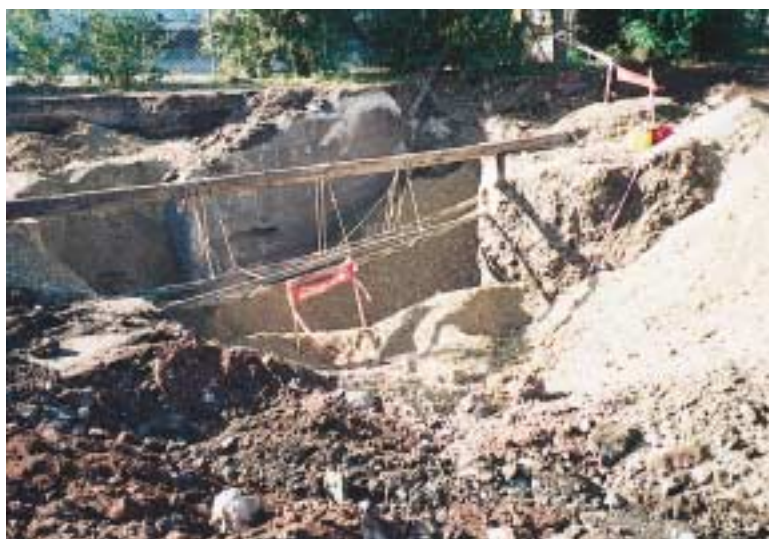
Photo 5 Défournement des scories chaudes au droit des conduites de gaz et électriques. Substitution par de la grave calcaire Removal of hot slag near gas and electricity lines. Substitution by limestone aggregate
