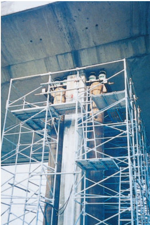
Photo 4 Vérins et système de descente de charge
