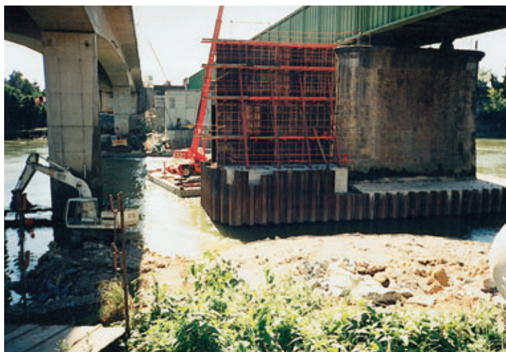
Photo 5 Grue mobile sur ponton pour la réalisation des élévations provisoires
