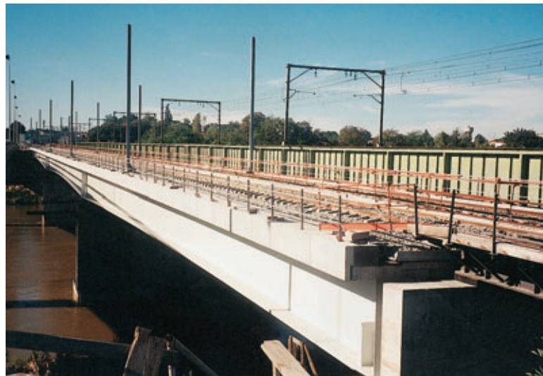
Photo 2 Ouvrage neuf en cours de réalisation, ouvrage métallique en circulation
