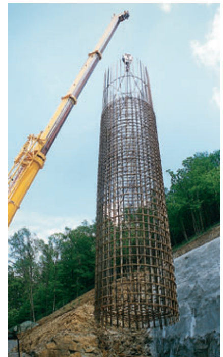
Photo 3 Ferrailage d'un puits Shaft reinforcement
