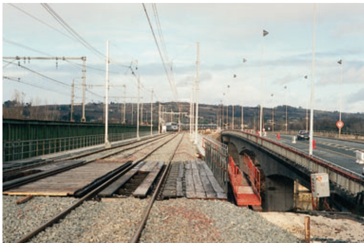
Photo 3 Tabliers auxiliaires en place avec circulation déviée Auxiliary decks in place with traffic diverted
