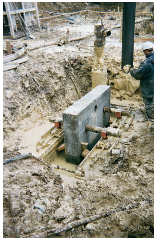
Photo 2 Dispositif de réglage des poteaux préfabriqués Precast column adjustment device
