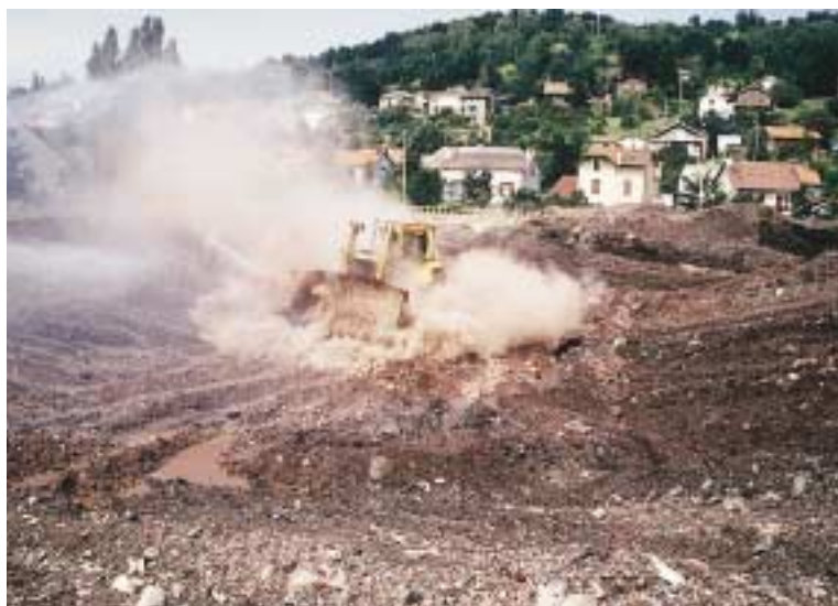
Photo 6 Emprunt de schistes rouges et gris chauds. Défournement au bouteur, par tranches Hot red and grey schist borrow. Removal by bulldozer and sections
