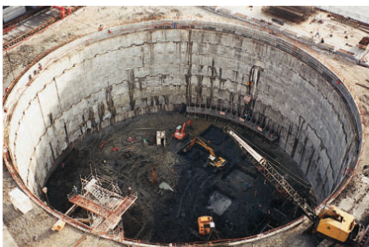
Photo 4 Anse des Régates : l'ouvrage à la fin du terrassement
