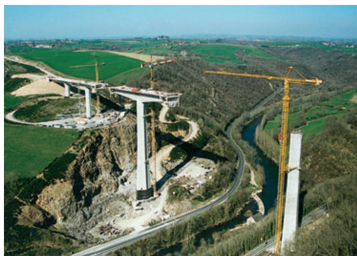
Photo 2 Vue générale de l'ouvrage en construction
