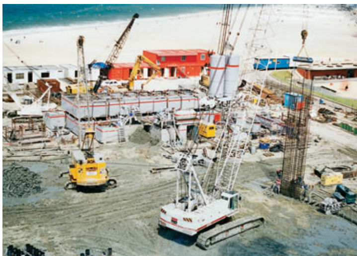
Photo 3 Anse des Régates : l'ensemble des installations. Mise en place d'une palplanche
