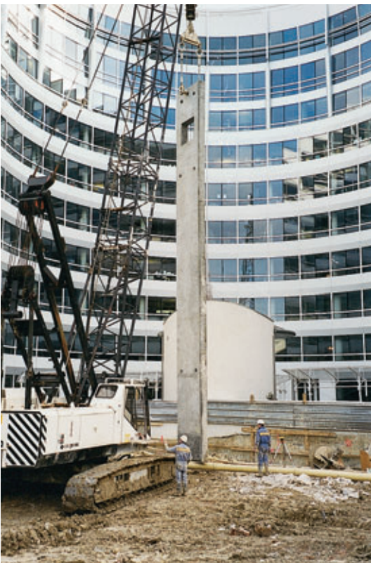
Photo 1 Manutention d'un poteau préfabriqué Handling a precast column
