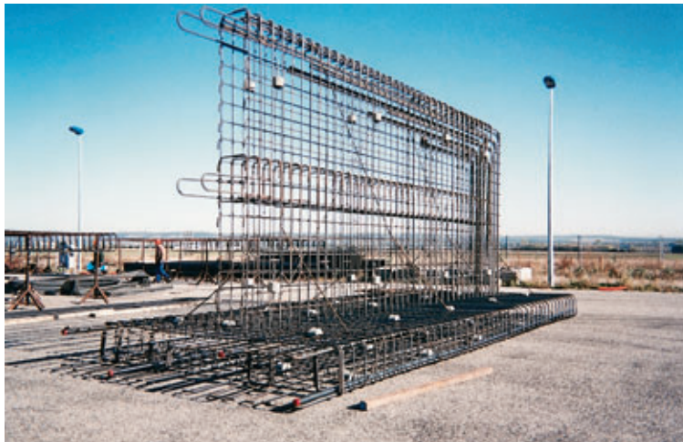
Photo 5 Val de Reuil : cage de ferrailage d'un "té" Val de Reuil: reinforcement cage for a "tee"
