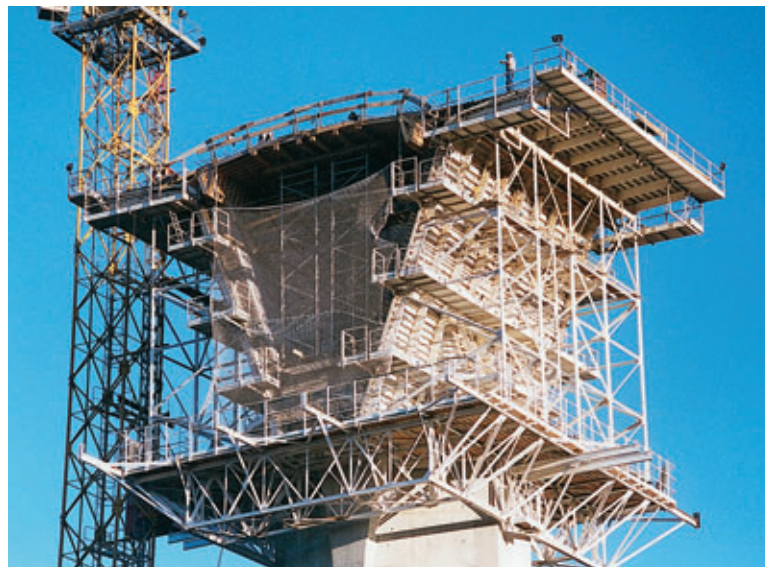
Photo 6 Coffrage du voussoir sur la pile 3 Formwork for segment on pier 3
