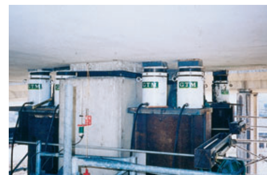
Photo 1 Vérins avec écrous de sécurité. Capteur de déplacement Jacks with safety nuts. Displacement transducer
