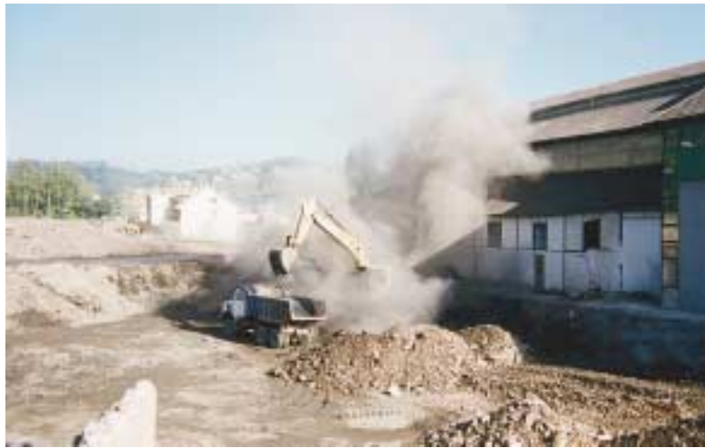
Photo 4 Bâtiment Transville : défournement des scories
