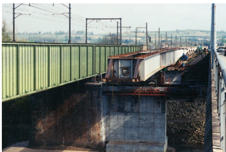
Photo 6 Lançage de la charpente métallique
