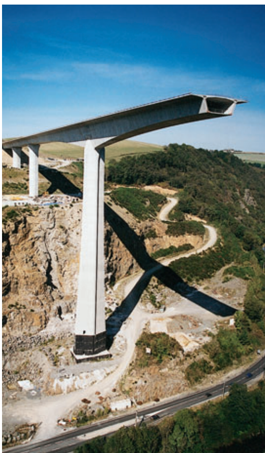
Photo 9 Finesse et élégance de l'ouvrage réalisé
