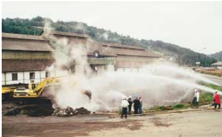
Photo 3 Début des travaux de défournement. Dispositif d'arrosage (lutte contre les poussières, refroidissement des engins de terrassements et des matériaux défournés)
