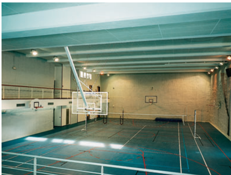
Photo 1 Vue de la grande salle avec les parois moulées apparentes
