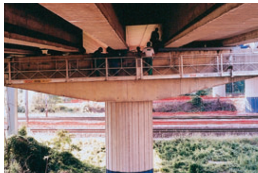
Photo 2 Vérinage par vérins plats Jacking with flat jacks
