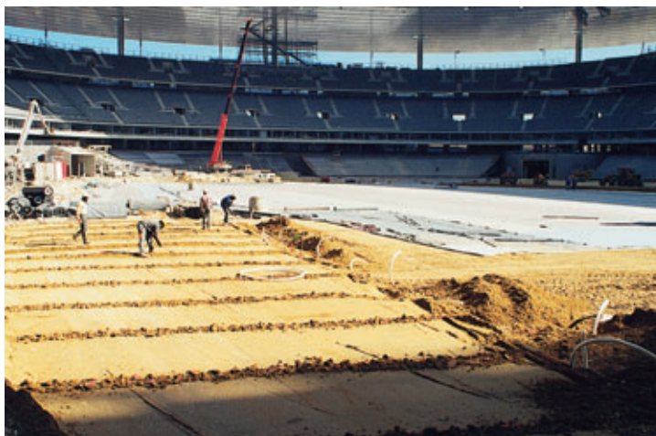
Photo 2 Travaux drains et membranes sous pelouse
