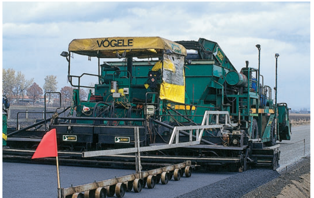
Photo 6 Mise en œuvre de la GB avec l'alimentateur et la poutre Placing a bitumen-treated base with the feeder and the beam
