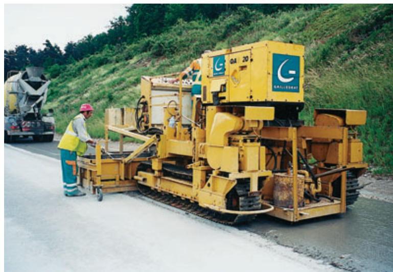
Photo 1 Colmatage des drainants avec un coulis cendres-ciment
