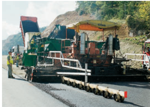
Photo 2 Guidage des finisseurs grande largeur avec deux poutres de 17 m de long
