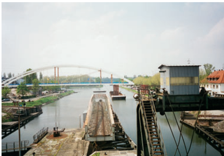
Photo 5 Vue du site lors du lancement de l'ouvrage depuis la rive sud vers la rive nord View of site during the launching of the structure from the south bank to the north bank
