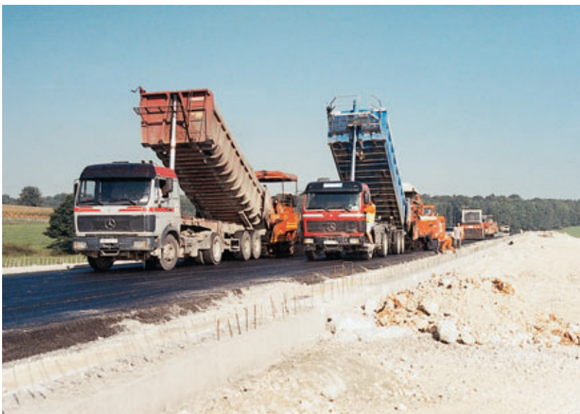
Photo 2 Atelier de mise en œuvre des G.B. 0/14 avec recyclés 0/14 BTM placement plant with recycled materials
