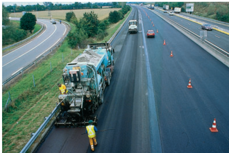
Photo 2 A 6 : mise en œuvre de l'ECF 0/4 sur la BAU
