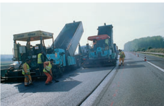
Photo 4 Mise en œuvre du BBTM 0/10 - Tapiflex Laying of 0/10 VTBC - Tapiflex
