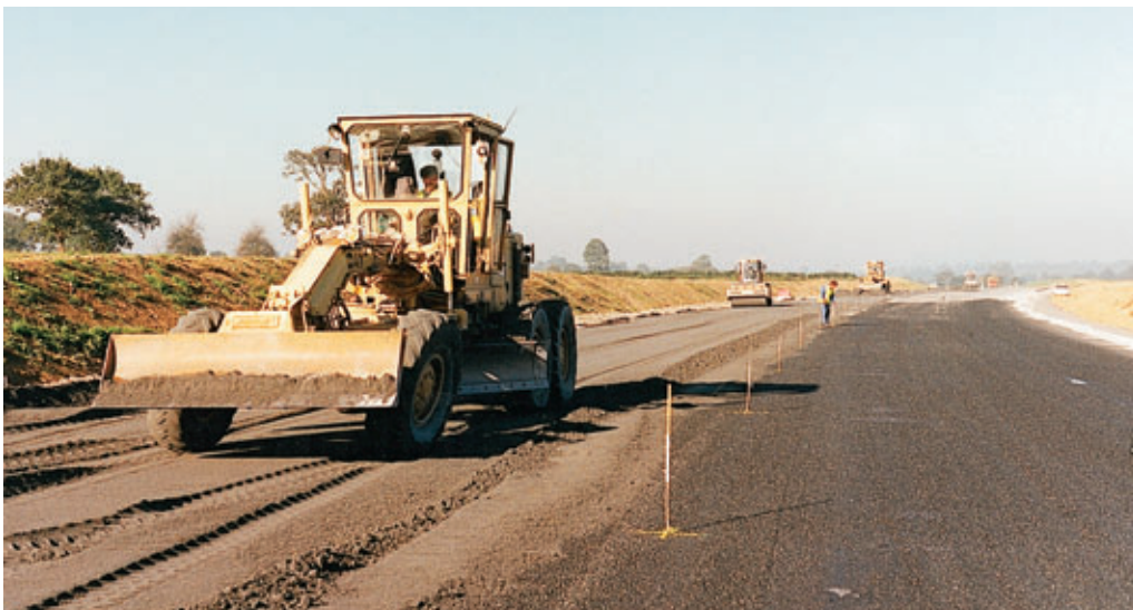
Photo 2 Niveleuse Caterpillar 14 G équipée du système de guidage Agtek. Réglage du sable traité Caterpillar 14 G grader equipped with Agtek guiding system. Levelling of treated sand
