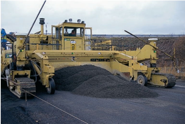
Photo 4 Application de la GRH avec l'autograde Application of RHGM with the autograde
