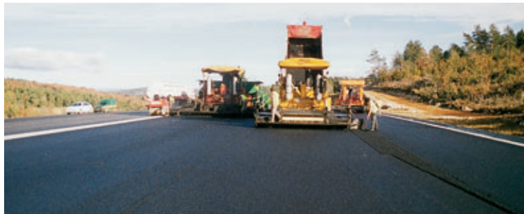
Photo 3 Vue de l'atelier de mise en œuvre des bétons bitumineux View of bituminous concrete laying equipment
