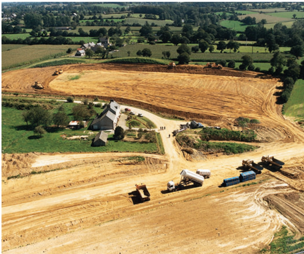
Photo 2 Remise en état d'un dépôt : après rehaussement par des matériaux excédentaires, les terres arables sont reconstituées couche par couche
