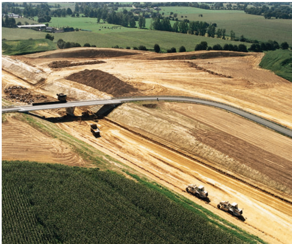
Photo 1 Préparation d'un dépôt : la partie supérieure du sol initial est stockée en deux tas séparés (terre végétale, limon) en fond de parcelle
