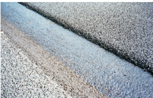
Photo 3 Vue des différentes couches : BBDr - ECF 0/4 - Emulpropre P - BBTM View of different layers porous asphalt - 0/4 microsurfacing - Emulpropre P - VTBC
