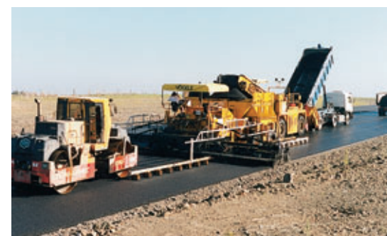
Photo 6 Finisseur Vögele S 2500 avec sa poutre de guidage pour le BB 0/10
