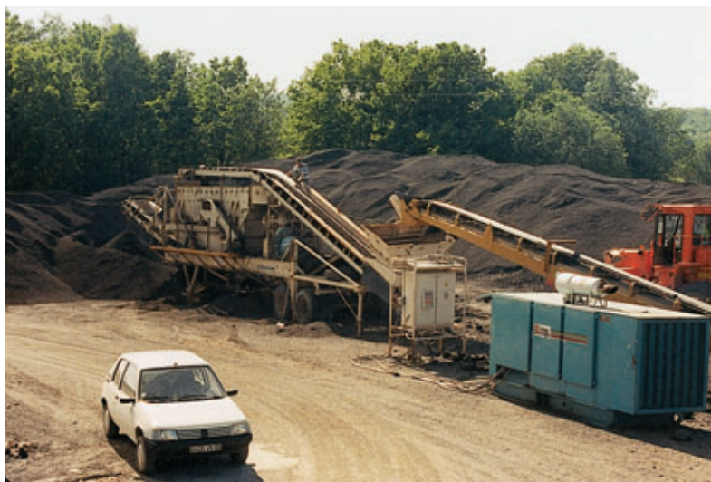
Photo 1 Installation de concassage des fraisats Milled material crushing installation
