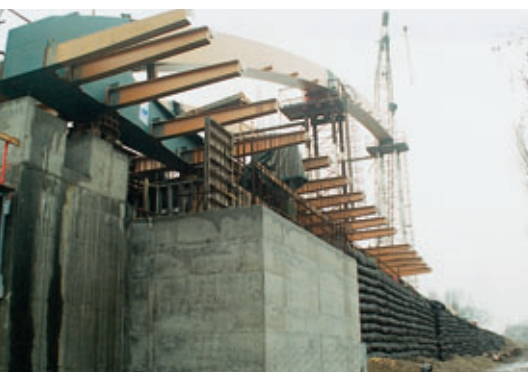
Photo 4 Les poutrelles en porte-à-faux du passage piétons-cycles The cantilevered beams of the pedestrian-cycle path
