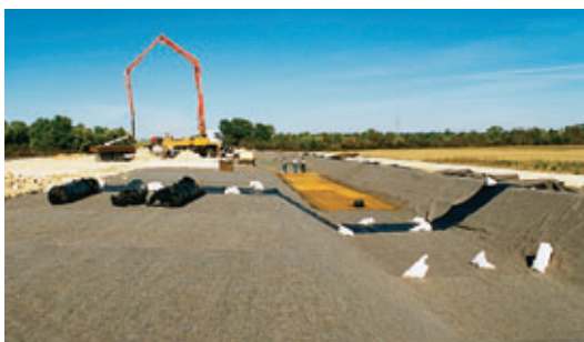
Photo 5 Etanchéité des fossés stockeurs Waterproofing of stocking ditches
