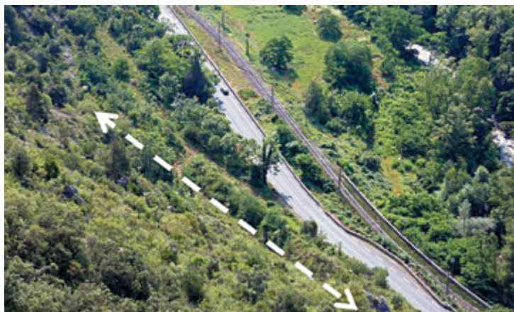
Figure BA1.4 Intégration paysagère d'un merlon à Villefranche-de-Conflent (Pyrénées Orientales) – l'ouvrage est totalement intégré dans le versant
