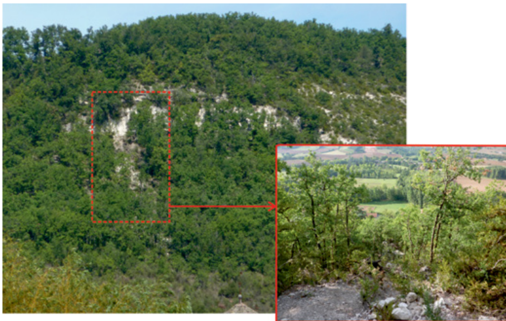
Figure D11.1 Tranchée déboisée suite à un éboulement rocheux – Vindrac-Alayrac (Tarn)
