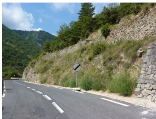
Figure D11.4 Revégétalisation naturelle sur colluvions et filet HLE (à 1 an) – Olette (Pyrénées Orientales)
