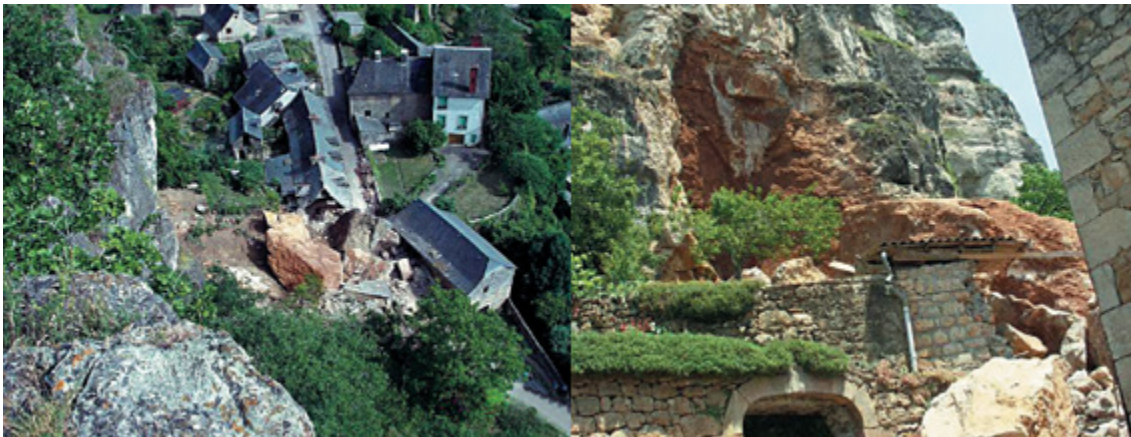
Figure Cas1.2 Éboulement du 23 juin 2005
