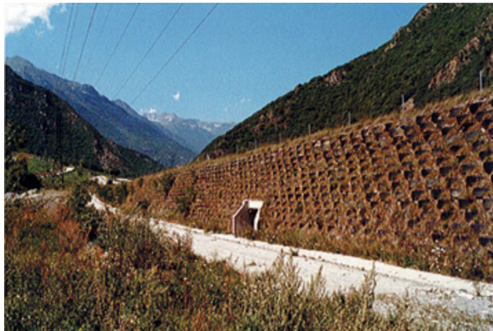
Figure BA1.3 Merlon en Pneusol – face amont – fosse de réception (vision résiduelle des pneus)
