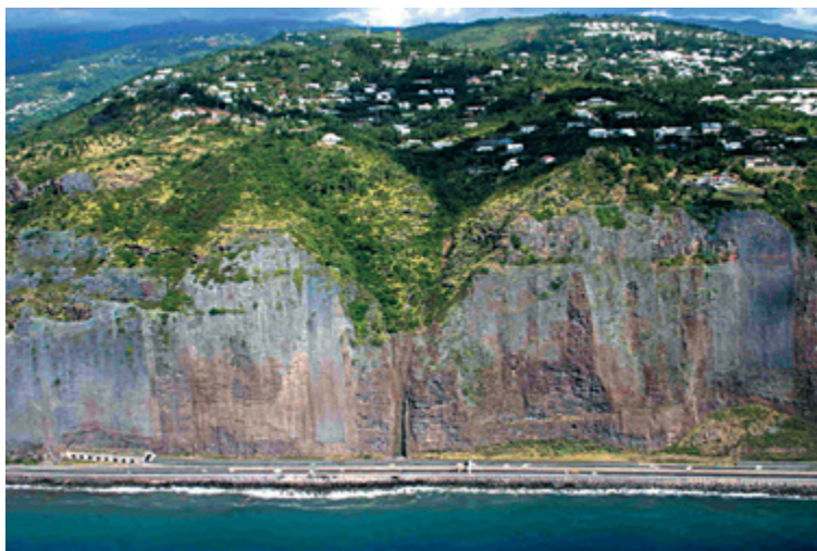
Figure DE1.2 Filet pendu 20 ans après la pose – en vue lointaine des talus, ils donnent un aspect lisse et grisé à la falaise – RN 1 (La Réunion)
