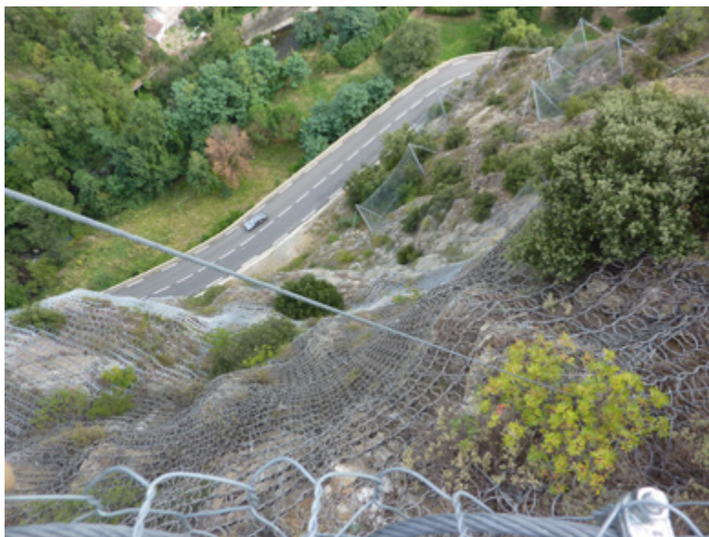
Figure D11.5 Revégétalisation naturelle sur filet à anneaux (à 10 ans) – Thuès-les-bains (Pyrénées Orientales)
