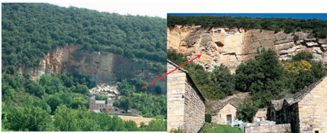
Figure Cas8.4 Éboulement au manoir de Vignals et vue rapprochée de la falaise
