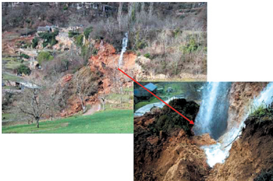
Figure Cas9.2 Éboulement du 10 décembre 2007 au niveau de la cascade de Laroque
