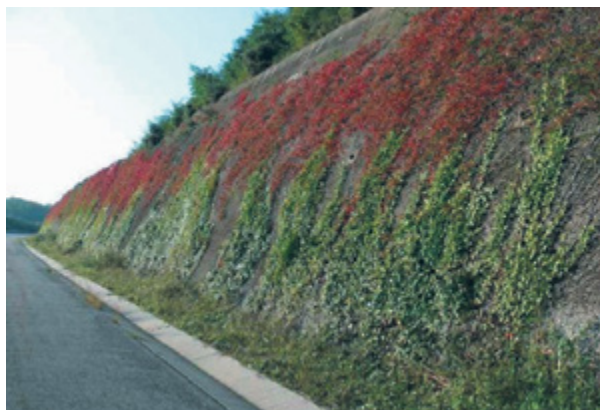
Figure D11.2 Végétalisation d'un béton projeté – tunnel de Foix (Ariège)
