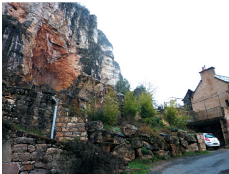
Figure Cas1.3 Vue de la zone débarrassée des éboulis, en 2013 : on distingue la cicatrice de teinte ocre sur la falaise
