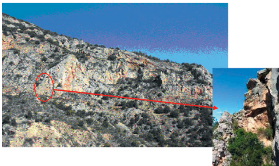
Figure Cas6.3 Colonne rocheuse à emmailloter avec filet anti-sous-marin
