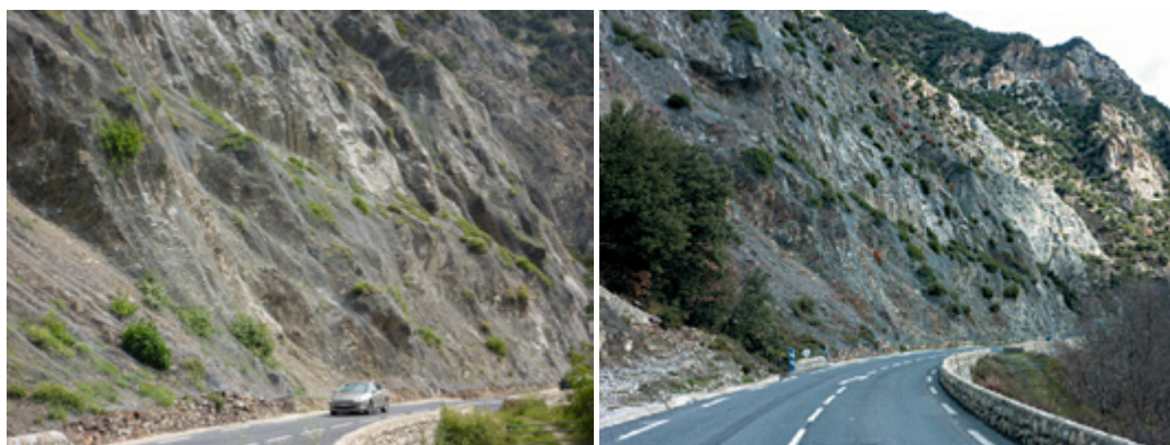
Figure D11.3 Revégétalisation naturelle sur grillage plaqué (à 4 mois et à 18 mois) – Thuès entre Valls (Pyrénées Orientales)
