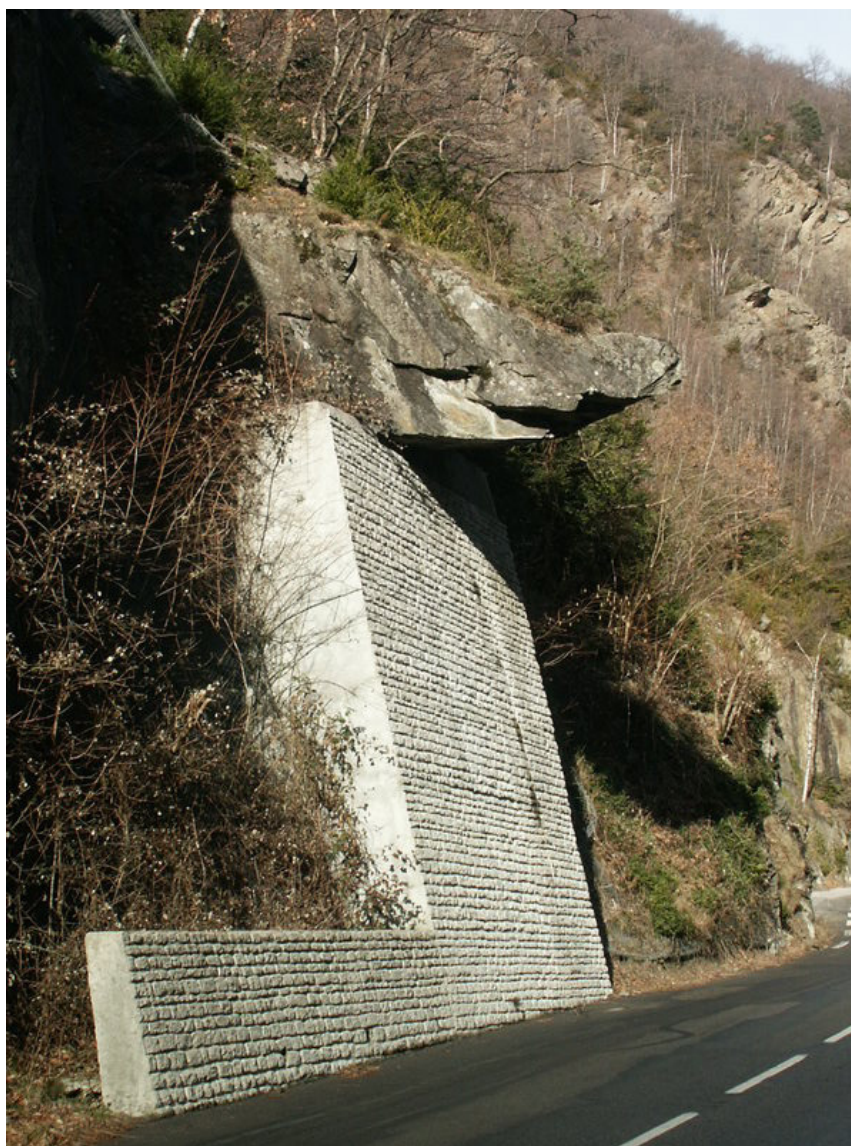
Figure SC1.1 Buton réalisé sur la RD 2205 (Alpes-Maritimes)
