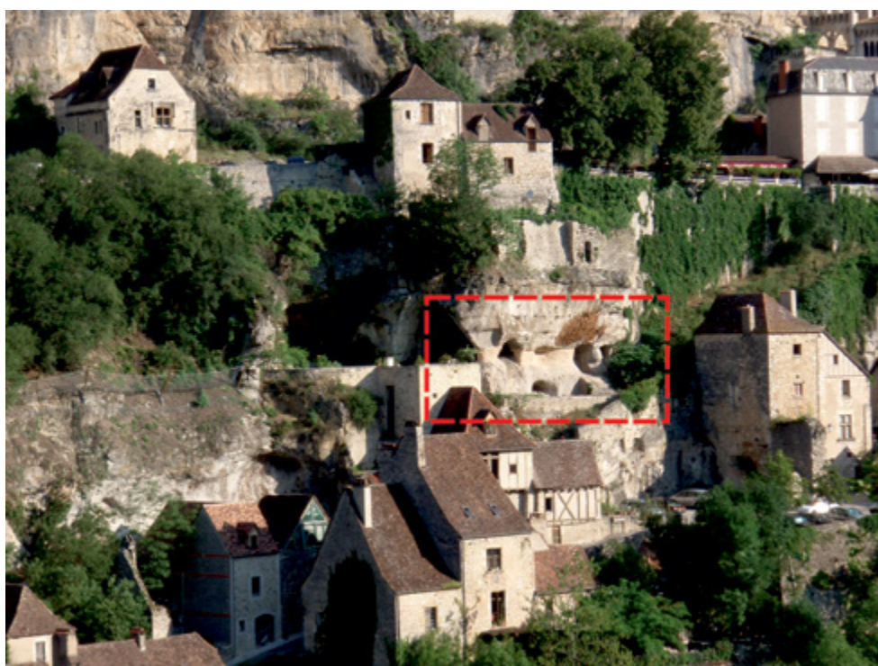
Figure SC3.4 Béton projeté teinté à Rocamadour (Lot)
