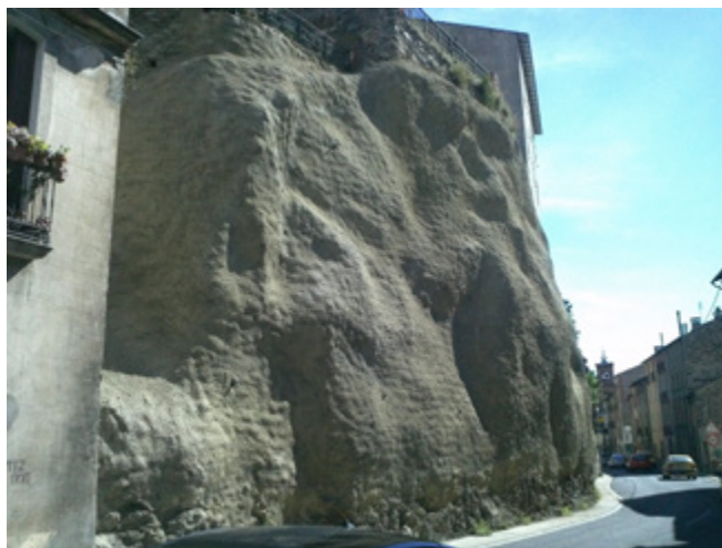
Figure SC3.3 Béton projeté à Olette en contexte urbain (Pyrénées Orientales)
