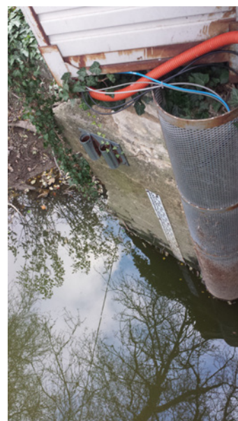
Figure 20. Installation du pont du Sanglier : montage sur paroi protégé par une crépine.
