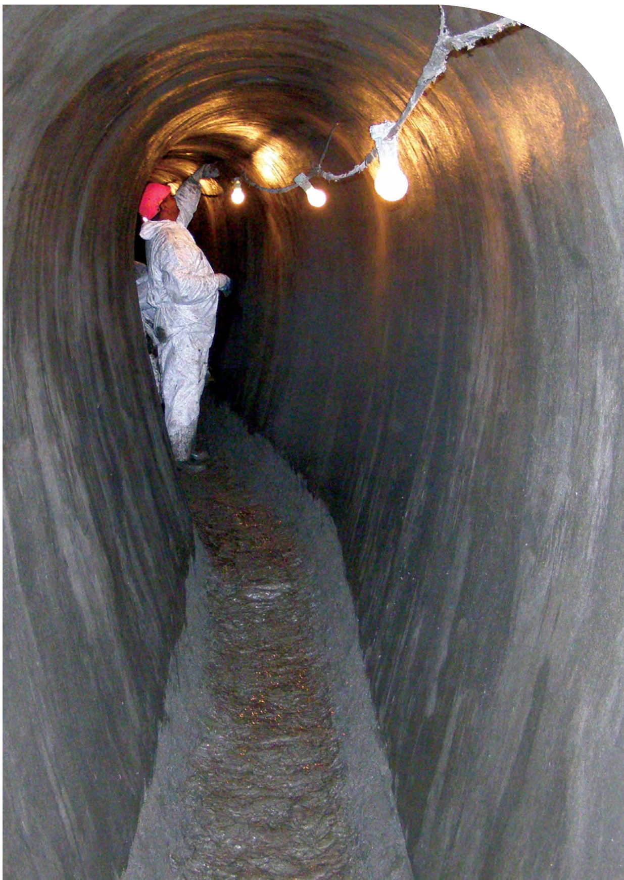
Finition travaux de béton projeté COLLIGNON
