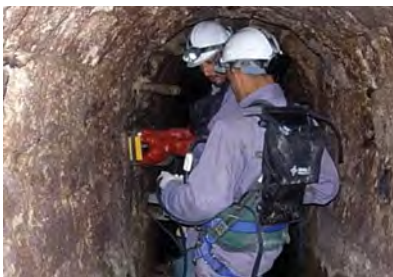
Diagnostic de collecteurs visitables d'assainissement à l'aide d'inspection, d'auscultation géo radar et de prélèvement de matériaux AFLAK, 2008
