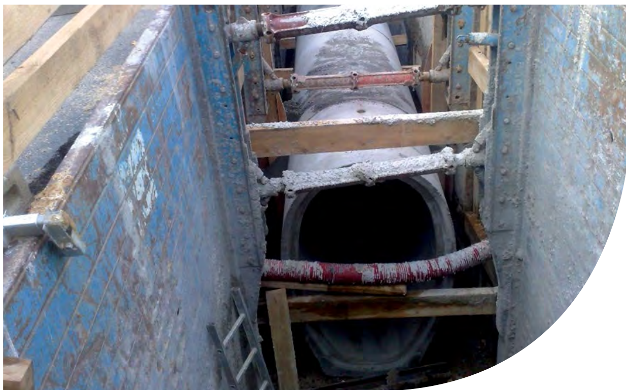
Remplacement en tranchée d'un collecteur unitaire d'assainissement AFLAK
