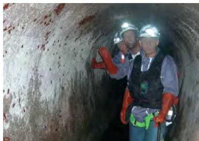
Diagnostic de collecteurs visitables d'assainissement à l'aide d'inspection, d'auscultation géo radar et de prélèvement de matériaux AFLAK, 2008
