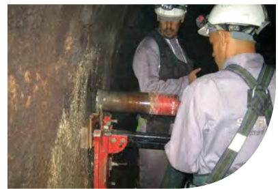
Diagnostic de collecteurs visitables d'assainissement à l'aide d'inspection, d'auscultation géo radar et de prélèvement de matériaux AFLAK, 2008
