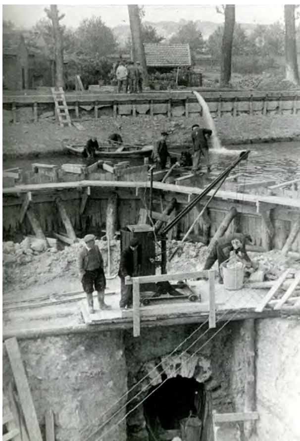
Reconstruction en 1944 suite à bombardement d'un égout sous le canal de l'Ourcq DEA CD 93
